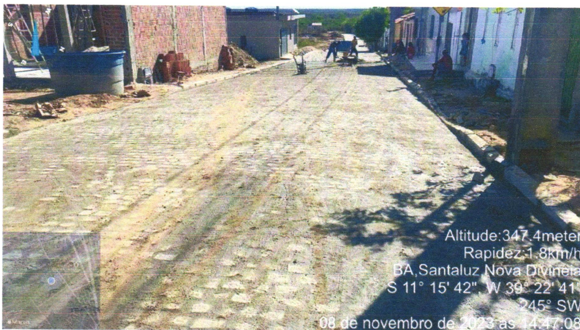
Execução de Pavimentação do Bairro Nova Divinéia, Rua F. Mascedo
